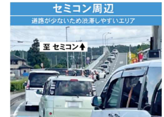
(写真:菊陽町道 南方大人足線(通勤時)) ※JR豊肥本線の跨線橋部を南側から望む
