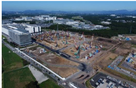
JASM第2工場（建設中）
