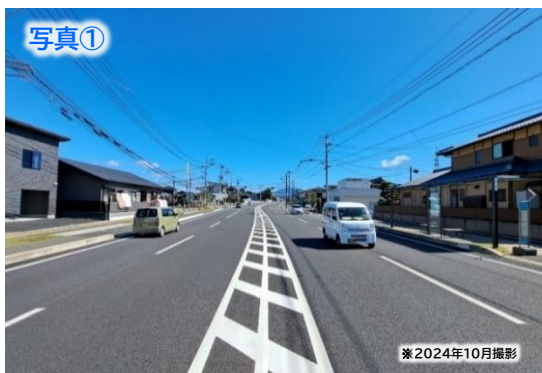
4車線での供用状況
