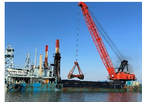
覆砂工事状況(R8.5 玉名市)
