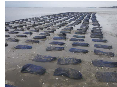
網袋設置状況(R7.4 玉名郡長洲町)
