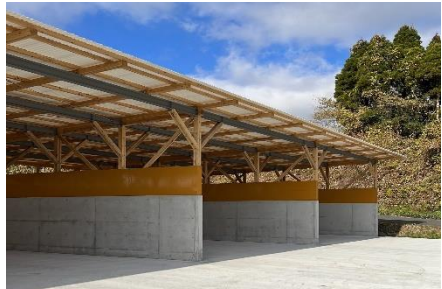
堆肥化処理施設
