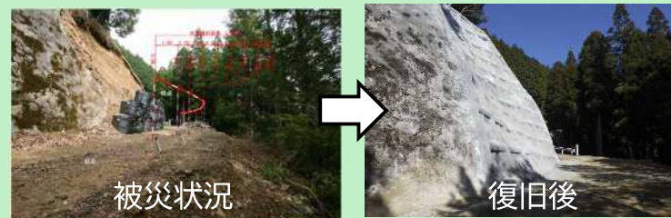
林道の法面復旧完了(五木村)
