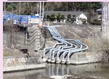
応急ポンプの設置状況(上天草市)
