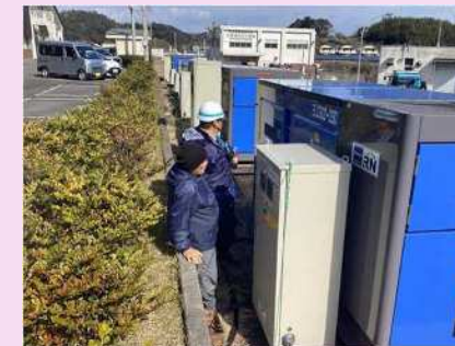
発電機の仮復旧状況(上天草市)
