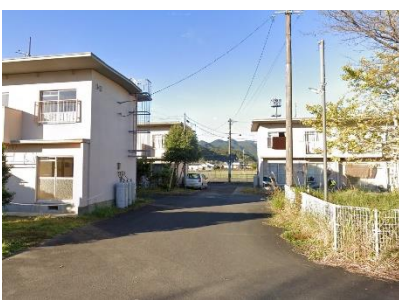
団地西側のⅠ-1棟～Ⅰ-3棟
