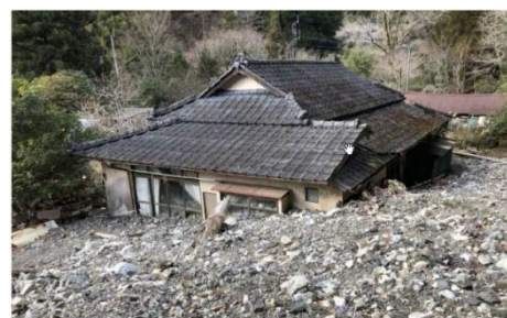
土石流による住宅被害
