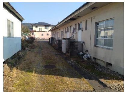
住棟間の通路
