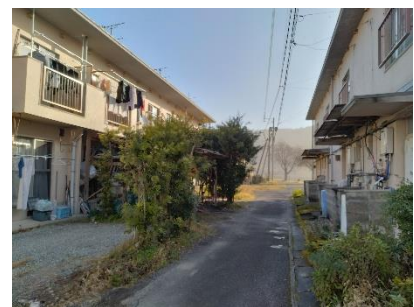
住棟間の通路
