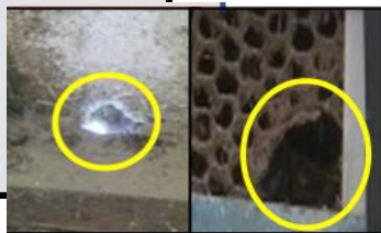
壁や天井の穴の補修
