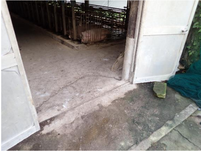
豚舎入口：消毒槽、豚舎専用長靴なし
