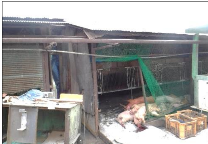
発生豚舎外観：靴底消毒は実施していたが、 長靴及び作業着の交換の実施なし
