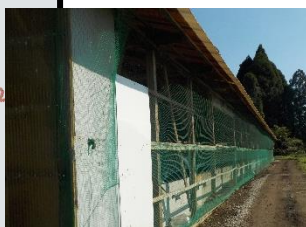
防鳥ネットの設置
