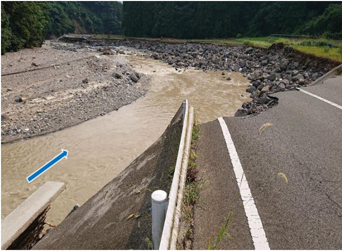
県道囲砥用線（筒川の堤防）（美里町）
