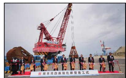
【耐震強化岸壁着工式 R6.6.8】
