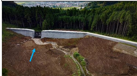
中山川砂防堰堤(高森町) 令和7年9月完成
