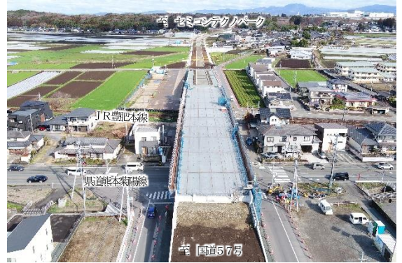
新山原水線 (羽場空港線) 整備状況
