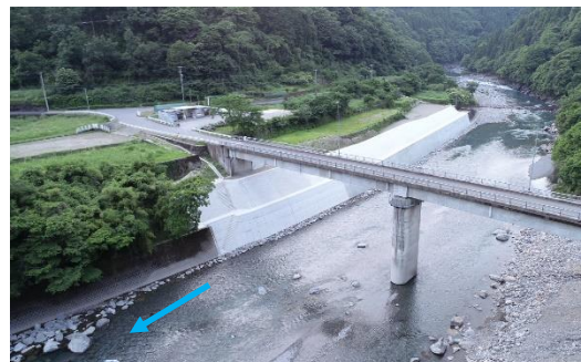
復旧状況（令和7年7月完了）
