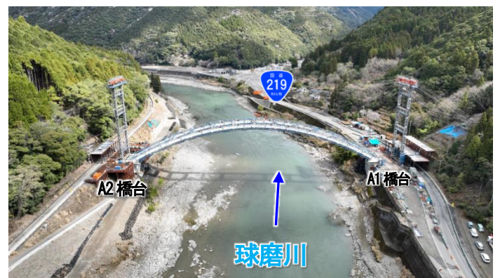
神瀬橋施工状況 (令和8年3月)
