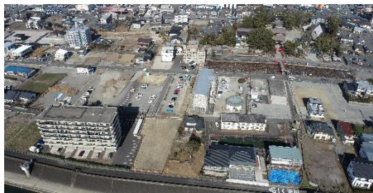
〔青井被災市街地復興土地区画整理事業 における宅地造成工事の状況〕
