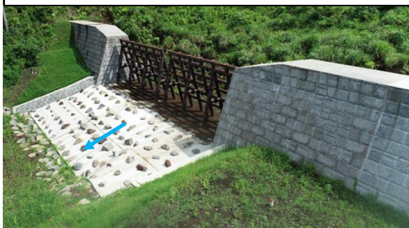
夜峰山2砂防堰堤(南阿蘇村) 令和6年3月完成
