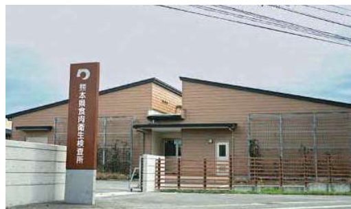
熊本県食肉衛生検査所（R2.11 完成）
