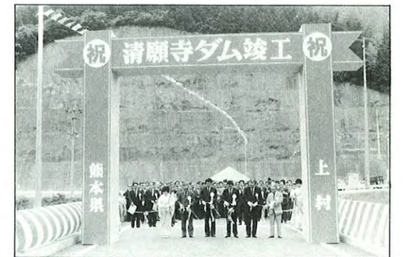
■ 県営清願寺ダム竣工 球磨郡上村の免田川上流に建設が進められていた県営清願寺ダムがこの程完成し、6月7日竣工式が行われた。このダムは、免田川流域の洪水調整と上村南部のかんがいを目的にしたもので、堤高60.5m、長さ19.9m、総貯水量332,000トンの中央コア型フィルダム。
