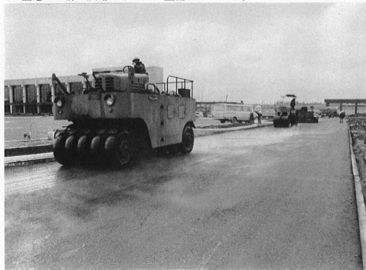
▼空港ビル前の広場もきれいに整備されていく。
