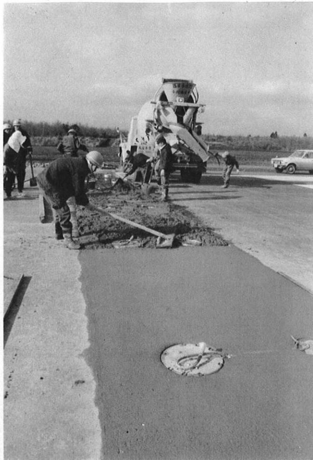
▲滑走路の末端を示す目印灯のとりつけ作業。
