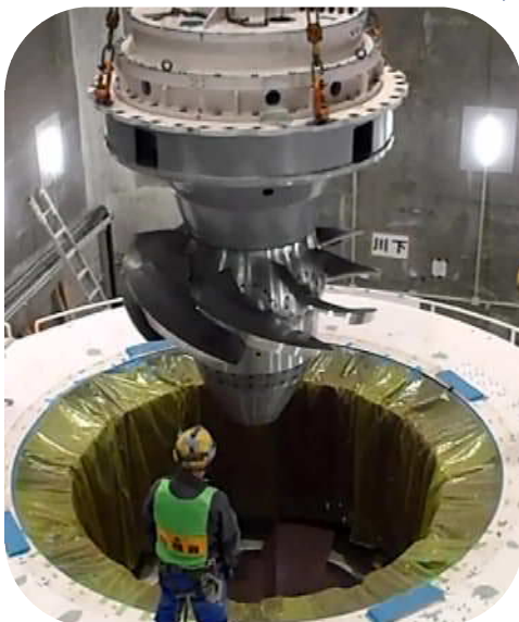
水車吊込み作業
