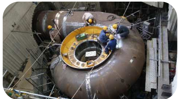
ケーシング取付作業
