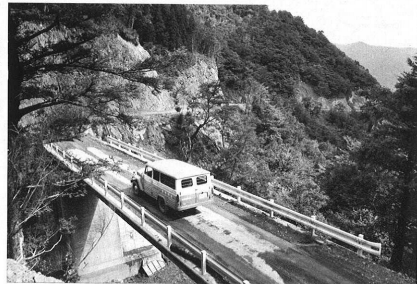
▶谷間にかかる橋もコンクリートの永久橋に。
