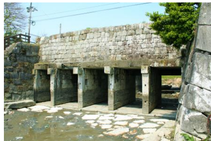
穀樋 (大鞘樋門群)
