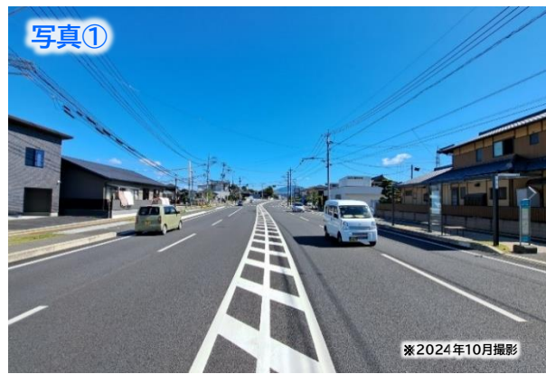
4車線での供用状況
