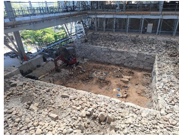
解体後の宇土櫓
