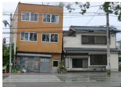
【液状化による建築物の傾斜】
