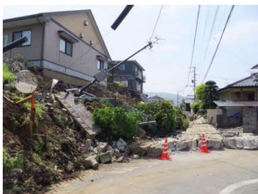
【盛土擁壁の被害】
