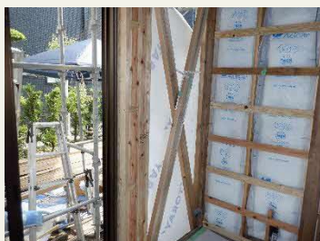
壁の補強(筋交い) (写真:熊本県)
