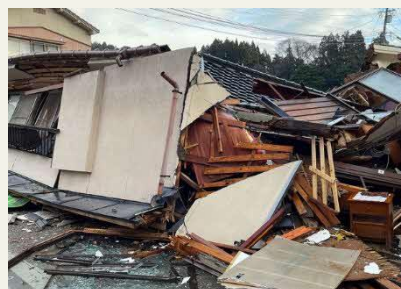
能登半島地震で倒壊した家屋(写真:国土交通省) (参考)国土交通省 HP 住まいの耐震化「家族を思う、強い家」
