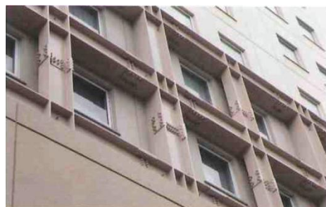
図 4.5.1 外付け鉄骨フレーム(耐震改修) (写真:国土交通省)
