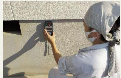
基礎の劣化状況確認 (写真:熊本県)
