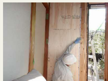
壁の補強(合板) (写真:熊本県)
