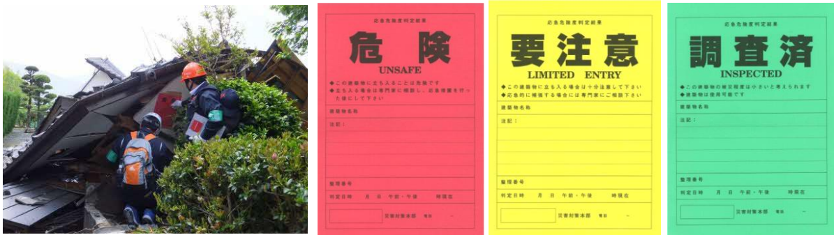
図 7.3.1 被災建築物応急危険度判定の様子、判定ステッカー（写真:熊本県）
