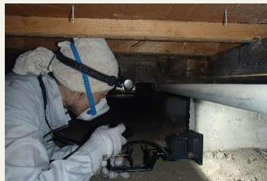
床下の確認 (写真:熊本県)
