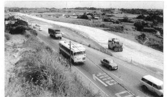
▲道路拡張工事を横に見ながら…。
