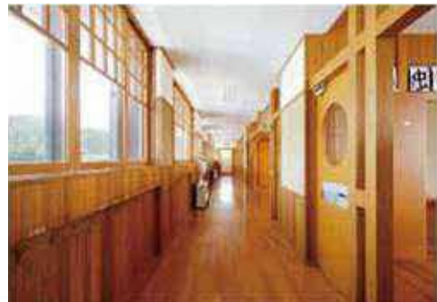
■学校廊下の木質化改修事例
