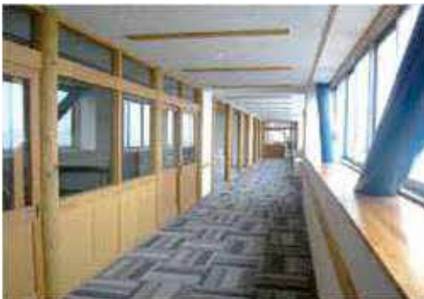
■耐震改修と間伐材の活用
