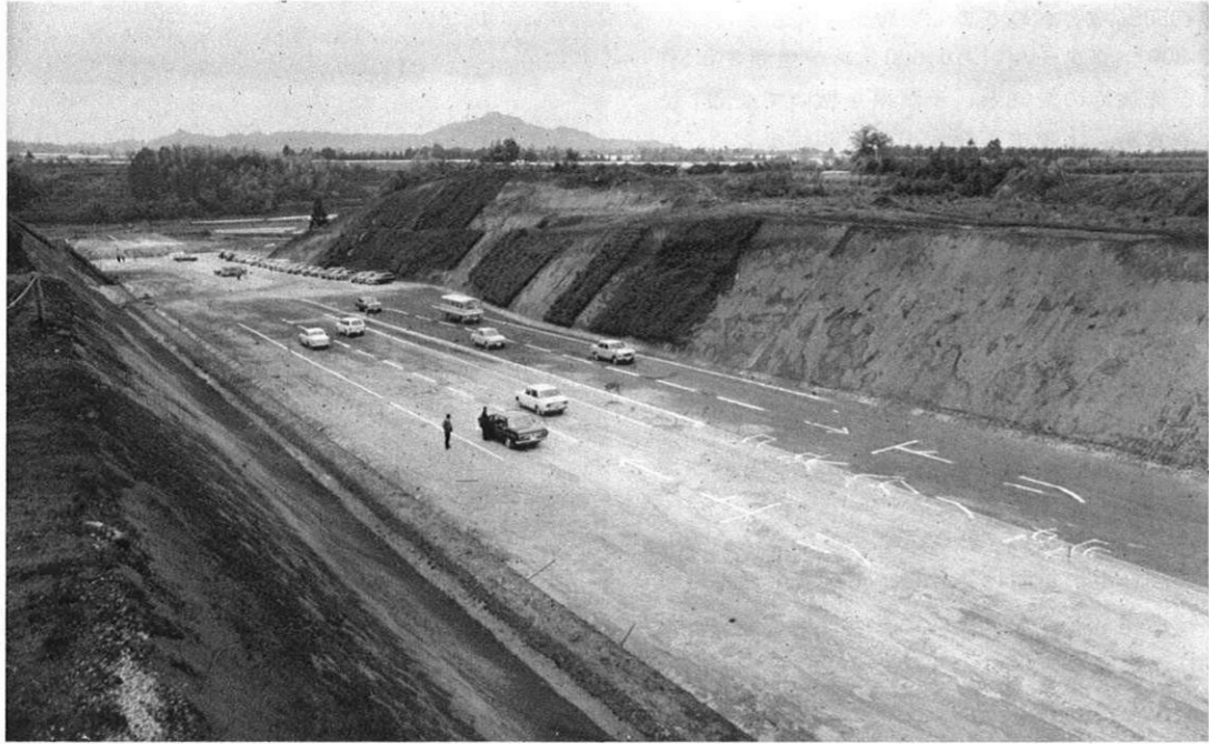
上・急ピッチの縦貫道建設工事現場。試験盛り土が完成した部分が見える。
