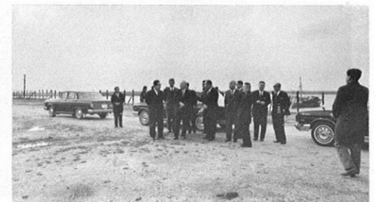
▲2.24 長洲地区に進出する不二サッシ工業の幹部一行が、知事の案内で建設予定地を視察した。
