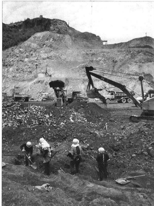
溪谷にハッパの音がこだまますダム建設現場
