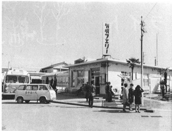
上・有明フェリー長洲事務所の全景
