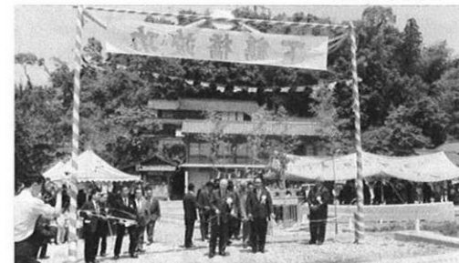
6.5—熊本・矢部を結ぶ下鶴橋(御船町)が完成。橋は鉄筋コンクリートづくりの永久橋。
