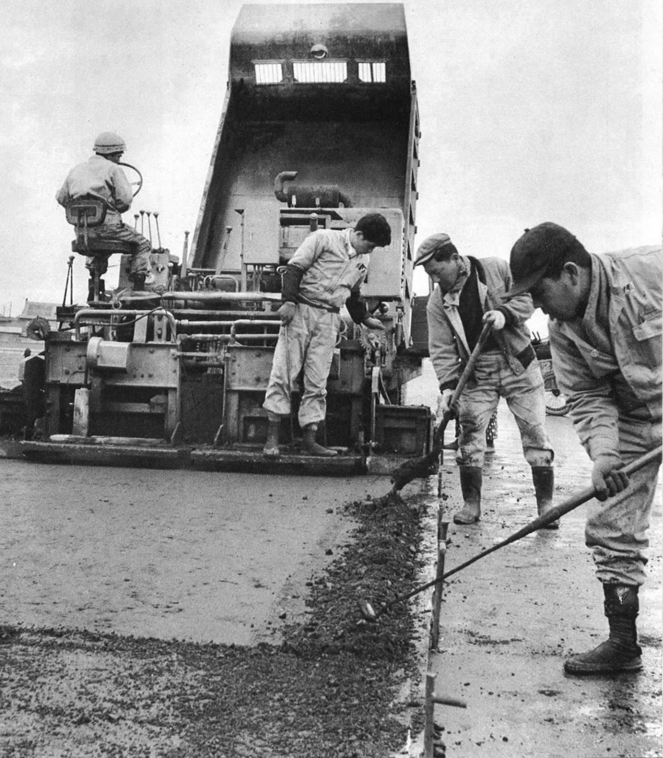
写真は道路舗装作業
