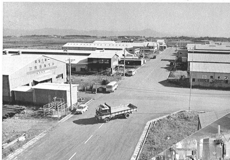
左・工場が新しい土地に集団で移転し、環境を改善し、生産性の向上をはかる工場団地も（託麻村にできた鉄工団地）
