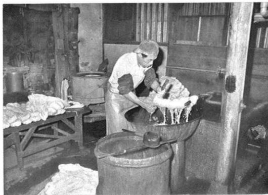
上・染めた糸も、白糸も、機械にかける前にのり付けする。
