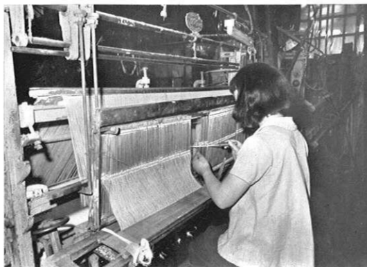
上・タテ、ヨコの糸を織り込む筈（おさ）通し作業
