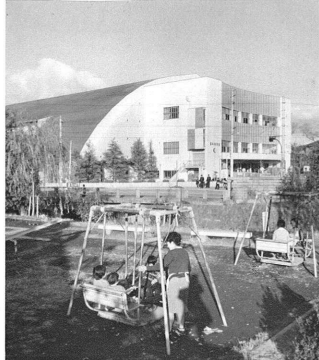
下・文化厚生福祉の充実にも力を入れている (熊本市体育館)
