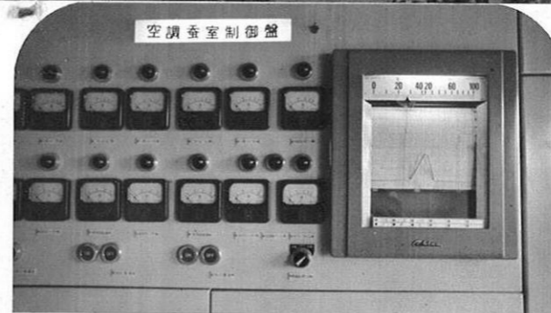
上・蚕室などの温度や湿度を自動的に調節する装置。
