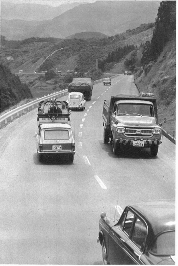
上・熊本と福岡の境界をつなぐ産業道路（小栗峠付近）
