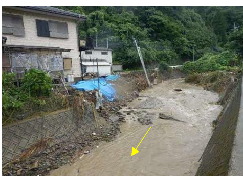
⑥ 宮の浦川護岸の被災状況
