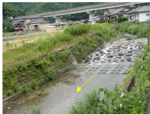
写真 1.23 取水堰(緩傾斜型)
