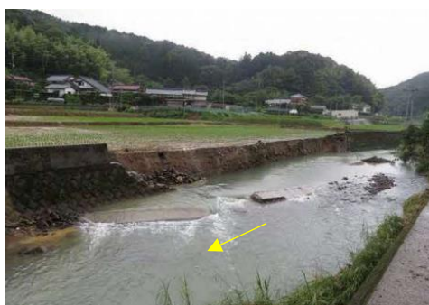
⑧ 田川川護岸の被災状況
