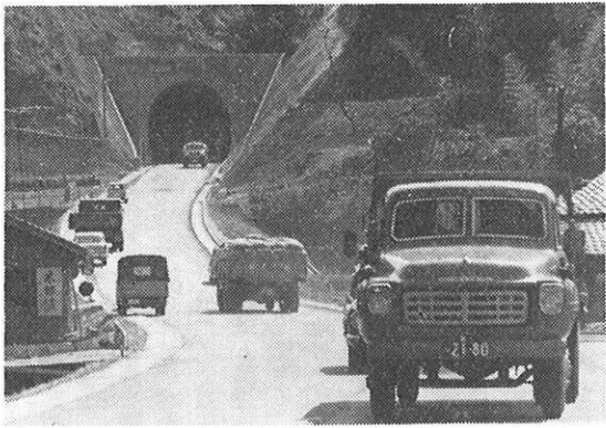
増大する道路輸送需要にこたえて整備された三太郎国道
