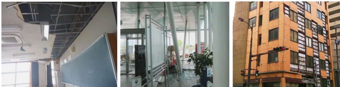
図 4.6.1 非構造部材の被害(天井・窓ガラス・外壁) (写真:熊本県)
