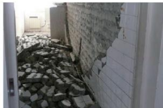
間仕切り壁の損傷
