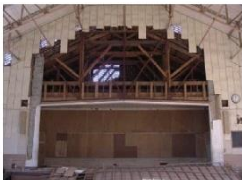
ステージ前部の壁の脱落
