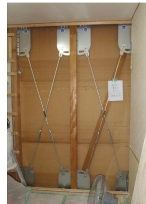
図 4.1.1 天井、床を解体せずに壁を補強する低コストの改修 (写真:NPO 法人耐震化アドバイザー協議会)
