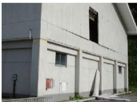
外壁材の脱落
