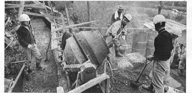
上・土木工事実習として災害復旧事業に...
