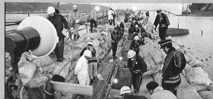
3・22 津奈木干拓湖止め作業が行われた。広さ45.3ヘクタール。完成は41年の見込。
