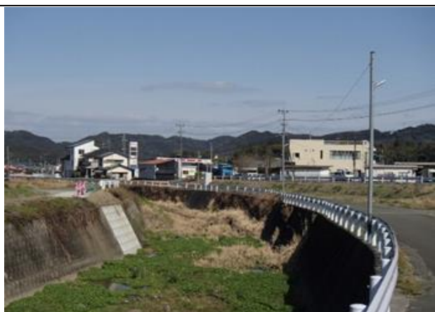
保全対象写真(人家)
