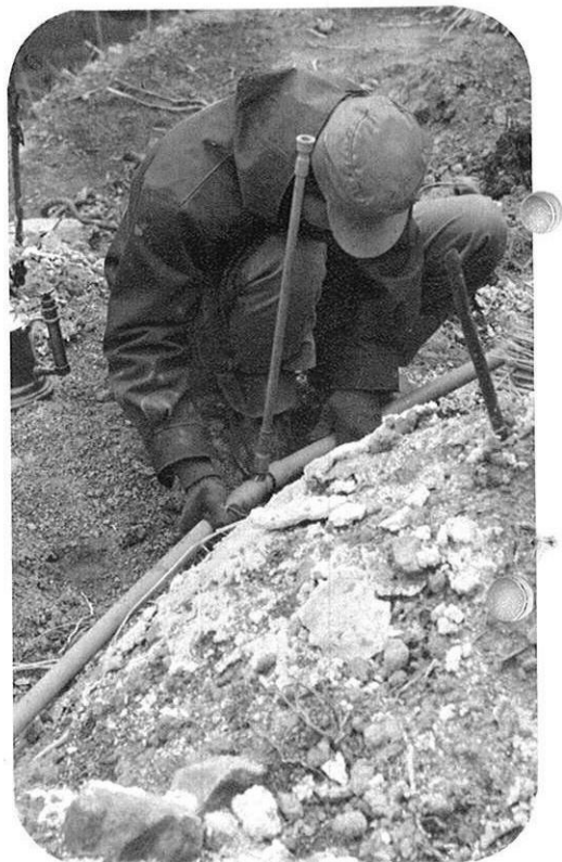
右・送配水用のパイプの取りつけ作業
