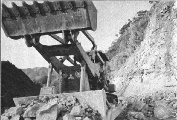
球磨川沿岸道路工事進む (7月)
