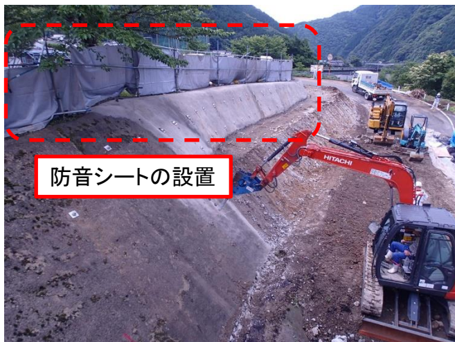
平場整備工事における防音シートの設置状況
