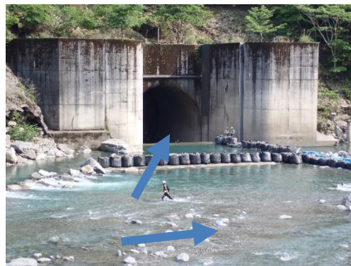
大型土のうによる導水状況(呑口)
