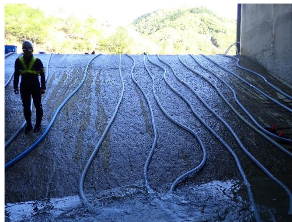
サイフォンホースによる導水状況 (呑口直下)
