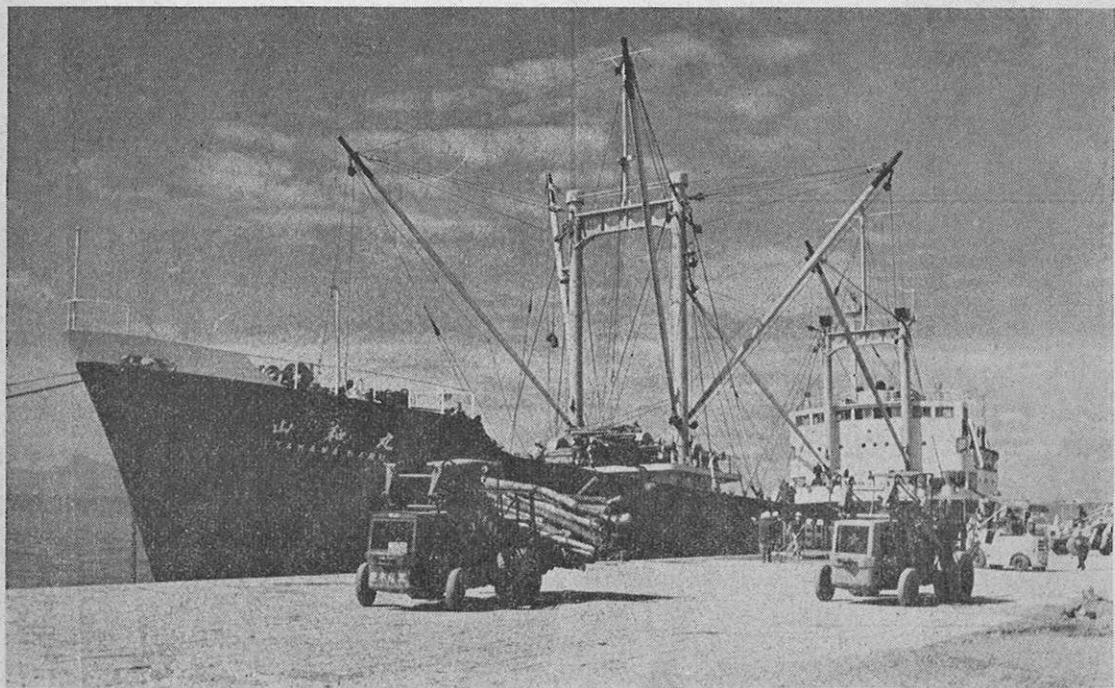
活況しめす八代外港……昨年11月に完成した八代外港は、いま千葉県からの砂鉄船、沖縄からのパルプ船など、大型船の入港がひきもきらず……さらに1万トン級岸壁や5千トン級岸壁もつぎつぎと工事が進められここ1、2年の間には「八代臨海工業地帯」の玄関として、大きな役割を果すことになろう。写真はパルプ材を積んで入港した大型船。
