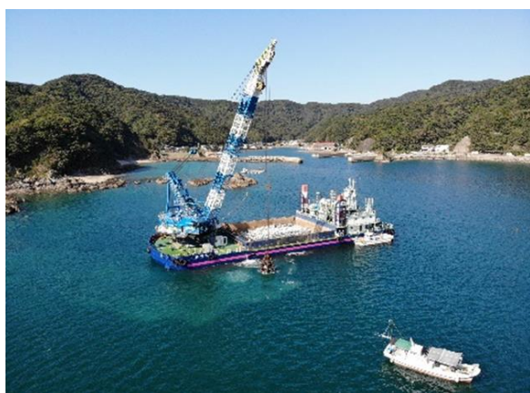
図4-3-7 藻場造成工事（投石）状況 (天草市軍浦)
