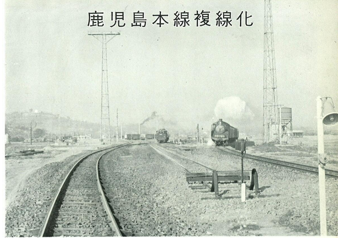
完成した白川操事場
