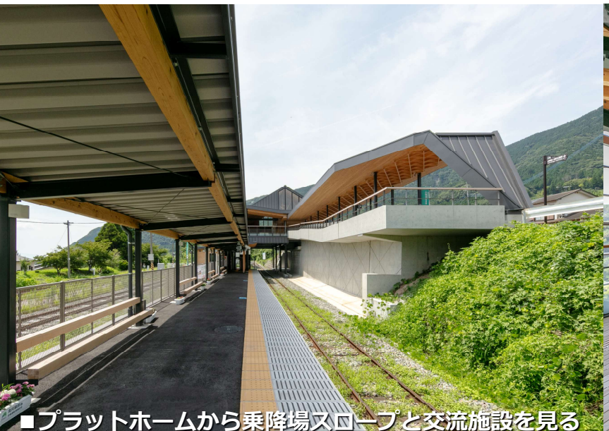
■プラットフォームから乗降場スロープと交流施設を見る
