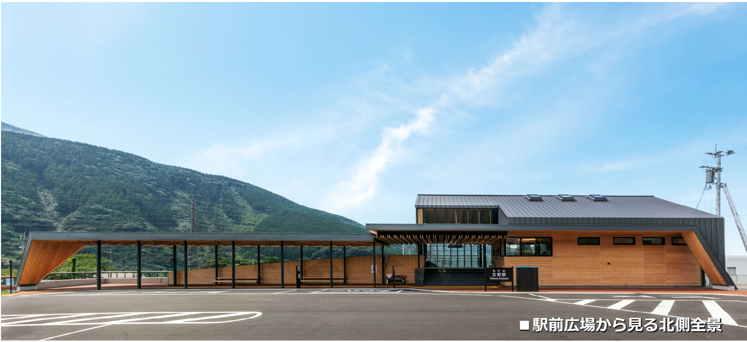
■駅前広場から見る北側全景
