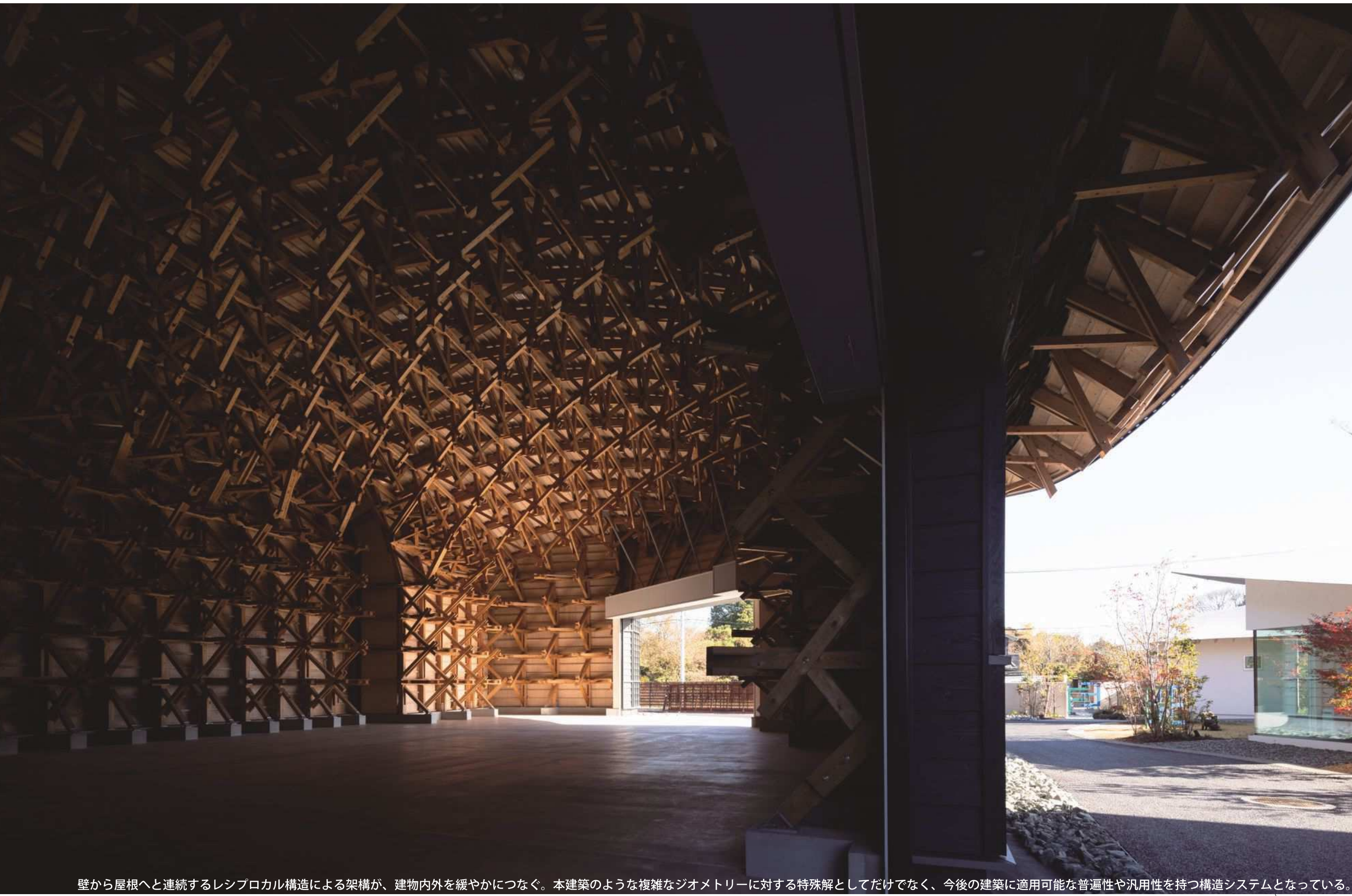
壁から屋根へと連続するレシプロカル構造による架構が、建物内外を緩やかにつなく。本建築のような複雑なジオメトリーに対する特殊解としてだけでなく、今後の建築に適用可能な普遍性や汎用性を持つ構造システムとなっている。
