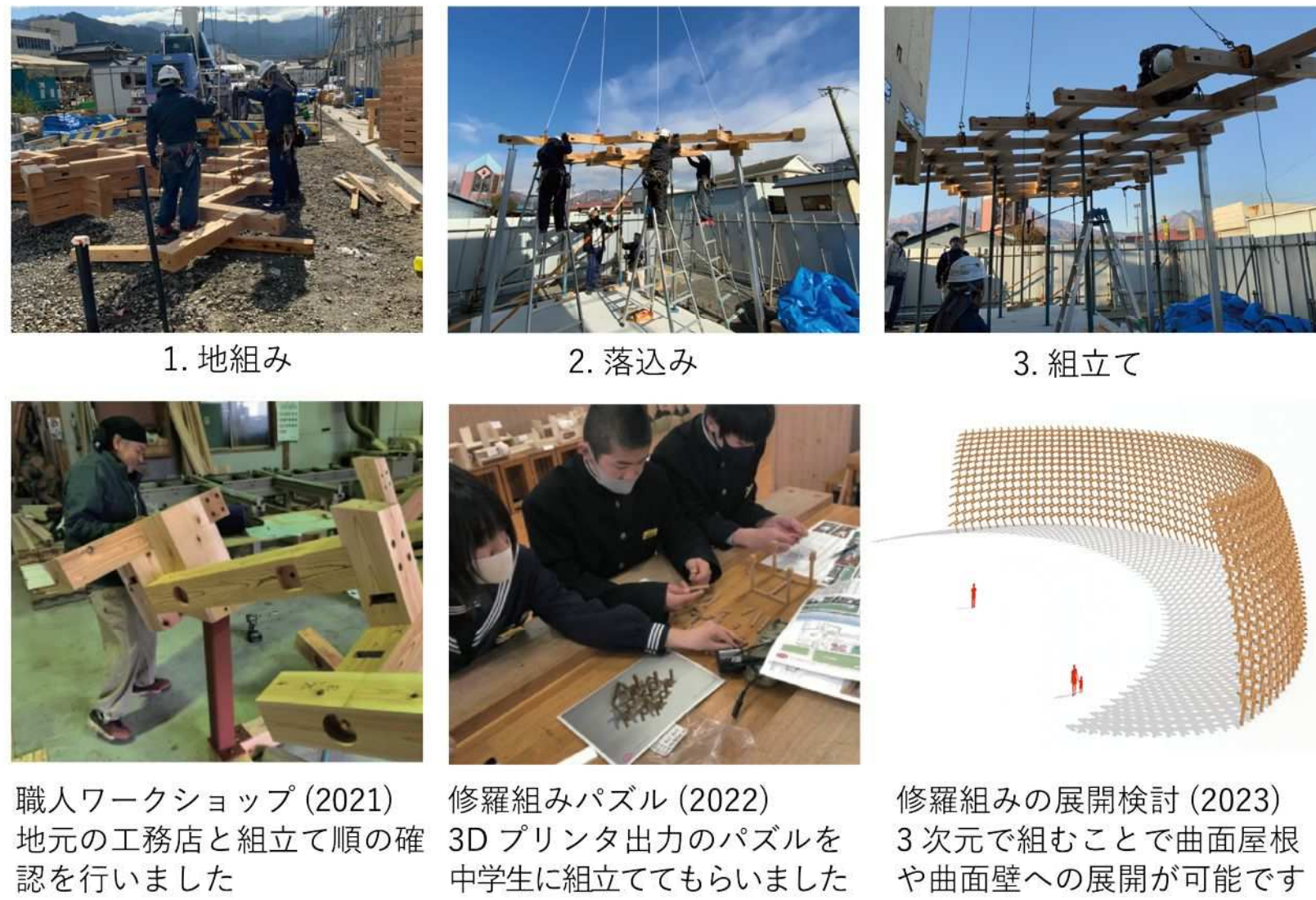
修羅組みの構造と組み立て方向
