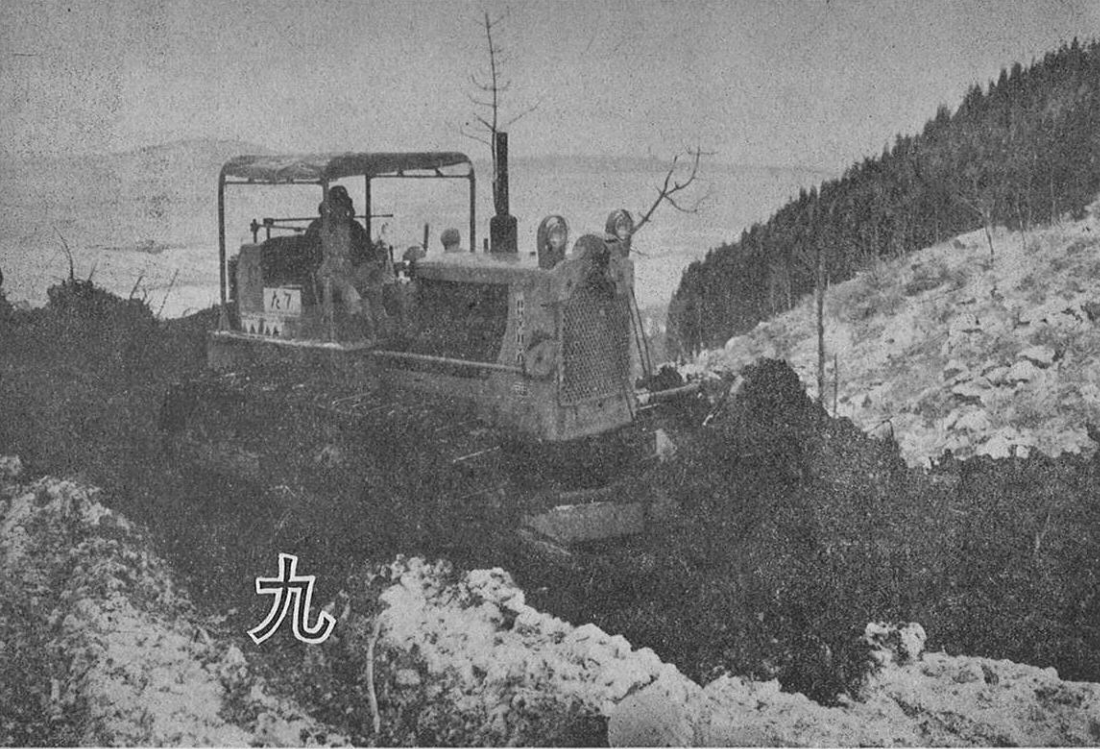
はるかに阿蘇五岳を望む瀬ノ本附近の工事現場
