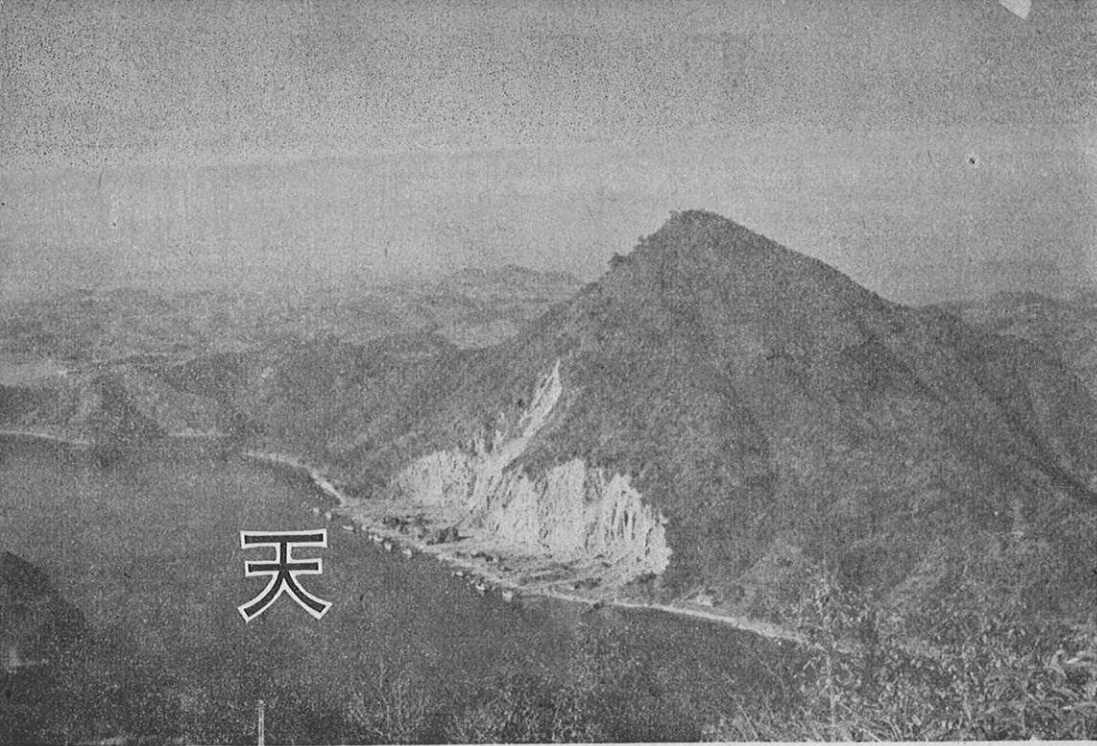
三角岳頂上から第1号橋の架橋地点を望む
