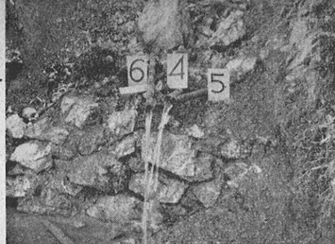
横穴式ボーリング工法……地下水が3本のパイプから流れている。
