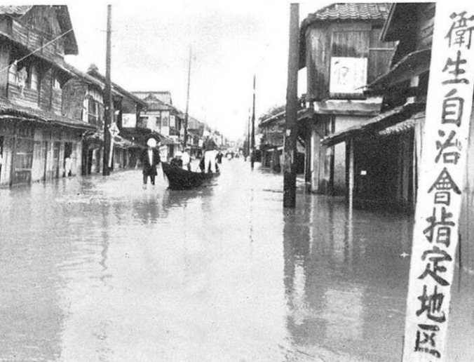
▲7月4日から5日にかけて城北一帯を襲った豪雨のため、 被害総額1億2千万円にのぼった。 ……写真は水びたしになった山鹿市内
