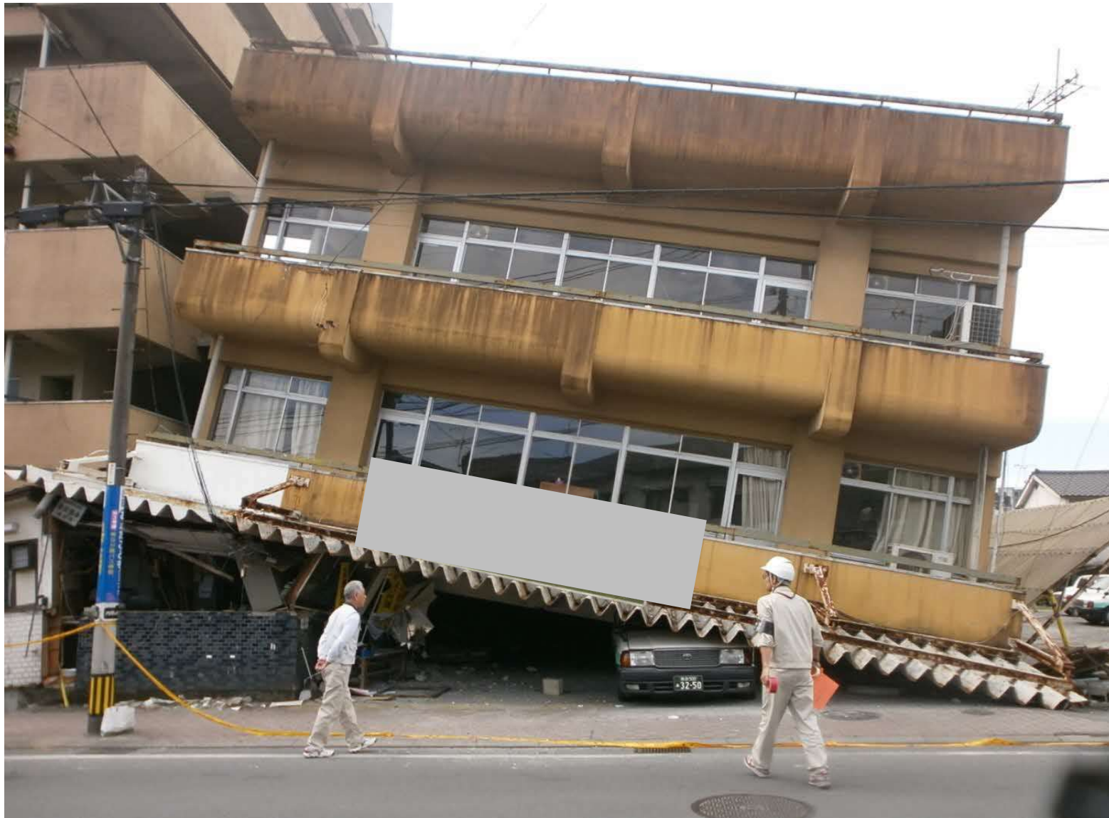
落階した建築物(熊本地震)
