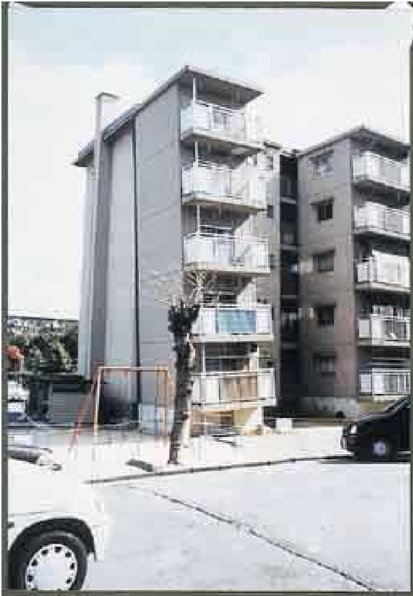
不同沈下のため傾斜した集合住宅
