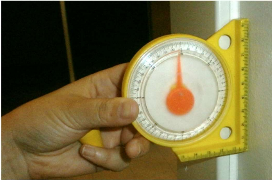
角度計を使用した傾斜の測定
