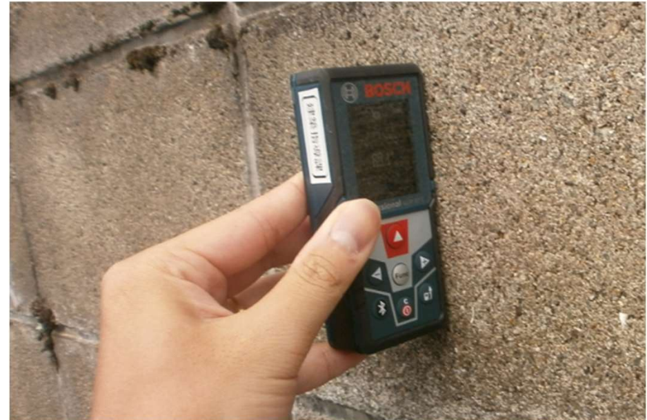
レーザー測定器を使用した傾斜の測定
